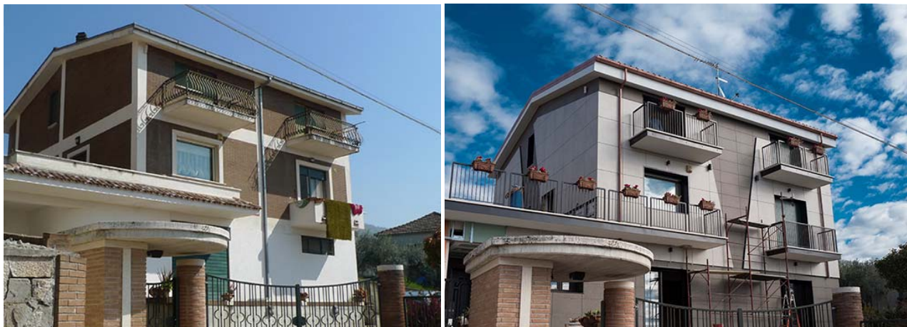
La villetta, prima e dopo l'intervento
