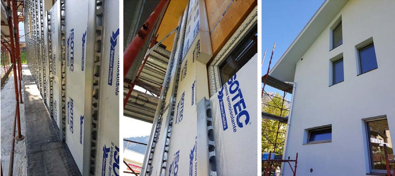
All'orditura metallica portante e ventilata creata con la posa del sistema ISOTEC PARETE sono state fissate lastre portaintonaco in fibrocemento, per ottenere una **tradizionale finitura intonacata** sulla maggior parte della superficie delle pareti esterne, mentre alcune porzioni della facciata ventilata sono state rivestite con **eleganti doghe in larice**, per un effetto estetico finale davvero ricercato.
