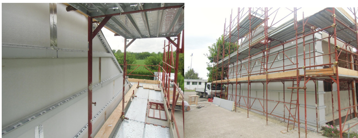
Le fasi di posa del sistema Isotec Parete
