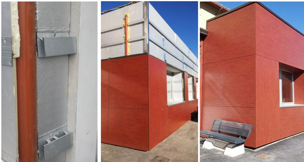
Il risultato è stato **un involucro perfettamente isolato, privo di ponti termici, ventilato e caratterizzato da un'estetica lineare ed originale**, che ben si sposa con l'architettura dell'edificio esistente e con il paesaggio montano circostante.
