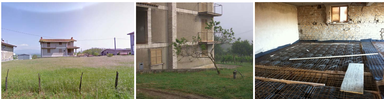
Lo stato dell'immobile prima e durante le opere di ristrutturazione
