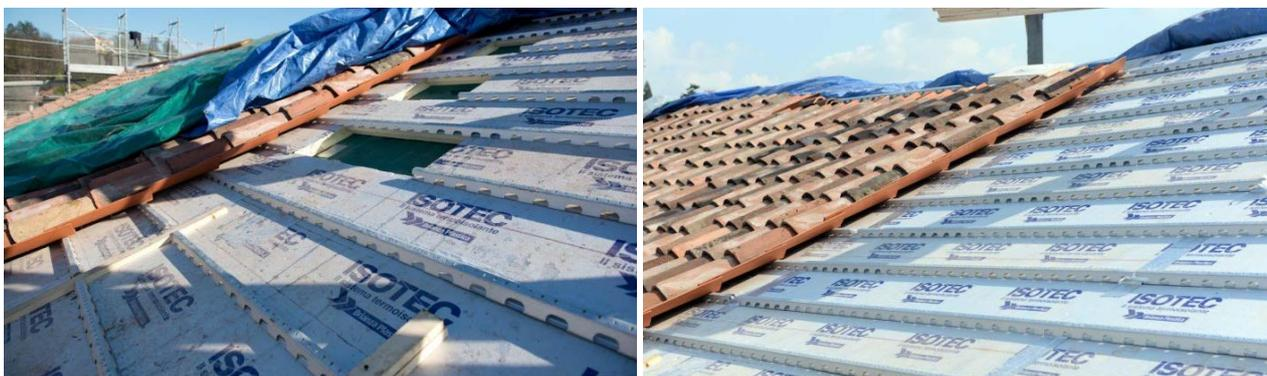
Il sistema ISOTEC è stato scelto per le sue caratteristiche di durabilità nel tempo e per la leggerezza, oltre che per il suo rivestimento in lamina di alluminio che garantisce una seconda impermeabilizzazione e un'efficace tenuta alle infiltrazioni accidentali. Il correntino metallico che consente la ventilazione sottotegola assolve, come detto, anche alla funzione di idoneo supporto alla posa dei coppi.
