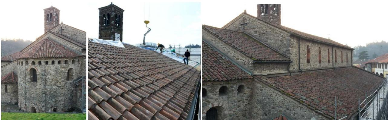
Le operazioni di ristrutturazione eseguite dall'impresa Teknorestauri srl di Barzago, hanno preso le mosse dalla **rimozione dei coppi esistenti**, accantonando quelli integri per il successivo riutilizzo, e dall'**eliminazione dello spessore del massetto** in sabbia e cemento.
