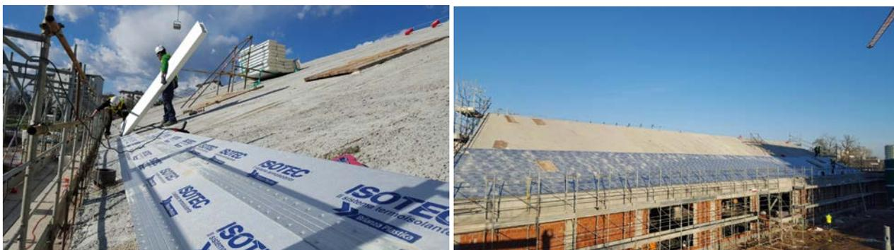
I pannelli ISOTEC LINEA, scelti nel passo 350 e spessore 120 mm, sono stati fissati in copertura con tasselli da 180 mm al calcestruzzo sottostante, assicurando la massima stabilità del pacchetto. Una volta sigillate le giunzioni dei pannelli, è stato posato il tessuto traspirante, per poi procedere al fissaggio del rivestimento in alluminio profilato in cantiere, ancorato mediante rivetti inox e graffette fisse e scorrevoli sul profilo in acciaio integrato nel pannello isolante ISOTEC LINEA.
