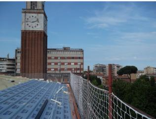
L'anima del pannello ISOTEC in schiuma poliuretanica espansa rigida autoestinguente, con densità 38 kg/m³, offre alla copertura e dunque all'edificio, elevate prestazioni di coibentazione, con conseguente **comfort abitativo ottimale** per ambienti ubicati all'ultimo piano, oltre a far registrare **significativo risparmio energetico**, grazie alla riduzione delle dispersioni termiche.
