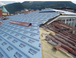
L'intervento di ristrutturazione della copertura si è reso necessario per le infiltrazioni di acqua meteorica dovute al deterioramento dell'impermeabilizzazione esistente e per migliorare in maniera sensibile il comfort abitativo nell'unità immobiliare posta all'ultimo piano del fabbricato, penalizzata dallo scarso isolamento termico presente.
