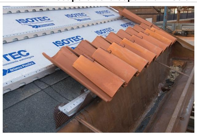
Tra gli interventi di restauro dell'esistente vi è il recupero della copertura. Si è trattato di un intervento completo sulla copertura lignea, consistente nel restauro delle capriate e sostituzione di parte delle travi di copertura primaria e secondaria, con pulizia delle travi, lievo della vecchia ferramenta, mano di antitarlo (per quanto concerne le travi rimaste in opera), formazione di nuove teste (nel caso di travi con appoggi troppo marcescenti) con due diverse metodologie di intervento.
