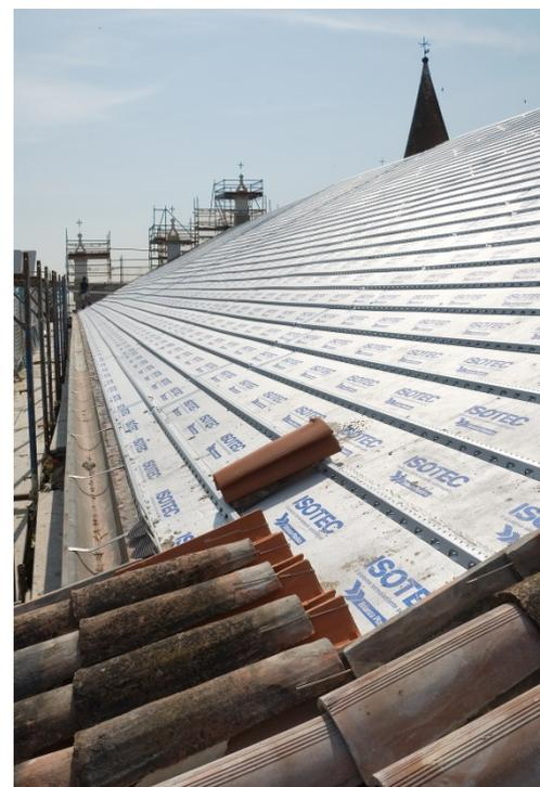
b) verifica dello stato di consistenza e funzionalità del manto impermeabilizzante; rimozione se in condizioni fortemente degradate o in alternativa pulitura dell'estradosso e riparazione delle parti manifestamente danneggiate;
