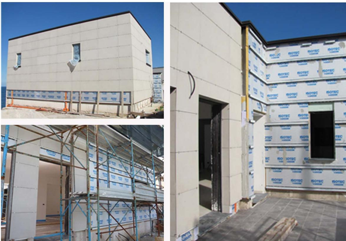
Come evidenziato nelle foto, il sistema **"ISOTEC PARETE"** si realizza in opera, con la posa dei pannelli prefiniti, prodotti in poliuretano espanso rigido (densità 38 Kg/mc) rivestiti con lamina di alluminio goffrato.
