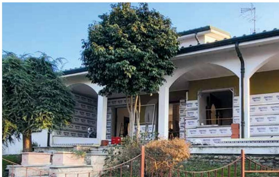
Ristrutturazione energetica delle facciate con finitura ad intonaco per una villetta a Vercelli (VC)
