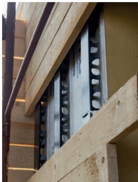
La struttura primaria è stata poi **integrata con ulteriori montanti e traversi**, ad un interasse di circa 60 cm, i quali hanno consentito la successiva installazione, sul lato esterno e tramite ancoraggio meccanico, dei pannelli Isotec Parete di spessore 120 mm e passo 400 mm, sia in parete che in copertura.
