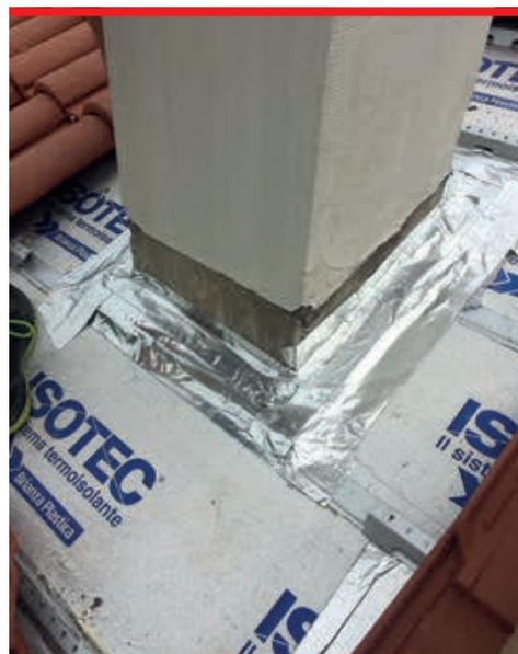
continui e discontinui e viene **fissato a secco**, mediante tassellatura. Questo consente di eseguire la posa in tutte le stagioni dell'anno e con qualsiasi situazione climatica, a vantaggio dell'**ottimizzazione dei tempi di cantiere**.
