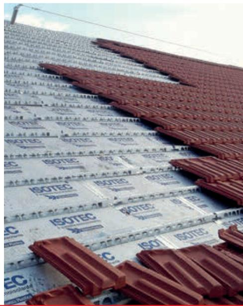
Tali accortezze sono state impiegate per il trattamento delle numerose discontinuità create dai comignoli e dagli abbaini che caratterizzano la copertura di questo edificio. **La possibilità di scegliere il passo del pannello, in funzione dalla dimensione delle tegole, ottimizza la lavorazione e il risultato finale.** La realizzazione di quest'opera - oltre 1600 mq di copertura - ha richiesto l'impiego di 2/3 persone per sole due settimane.
