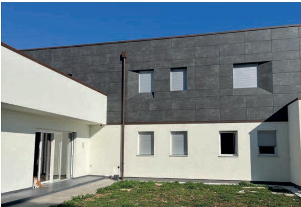
La definizione dei dettagli della facciata ventilata, come il trattamento e il raccordo delle particolari aperture, è avvenuta in sinergia con l'impresa Edilcolor San Marco, che ha posato il sistema in questo cantiere per la prima volta. **Isotec Parete** si è fatto apprezzare per la **semplicità di installazione**: veloce da posare sulle superfici continue, ma anche versatile nella realizzazione di particolari dettagli come gli imbotti con la ceramica a risvoltare.
