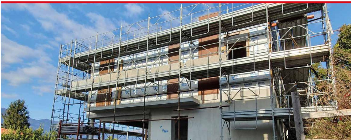
re il fissaggio di qualsiasi tipo di rivestimento, sia leggero che pesante. Per questo progetto è stato scelto, **per il rivestimento del piano terra**, l'abbinamento di Isotec Parete con **i pannelli in fibrocemento porta-intonaco Elycem**, una soluzione fornita a pacchetto da Brianza Plastica. **Per il piano superiore**, invece, Isotec Parete è stato rivestito con **originali doghe in alluminio con finitura effetto rovere** lunghe 3 metri e montate in verticale.
