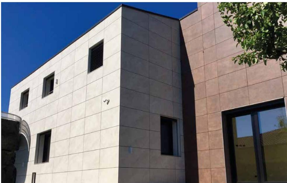
correntino metallico di colore nero per assicurare l'effetto-invisibilità fra le fughe. Le lastre in ceramica, dotate di taglio kerf e scelte nel formato 120x60 cm nelle due colorazioni grigio chiaro e corten, sono state fissate al correntino metallico con ganci a scomparsa, per un effetto estetico di grande eleganza.
