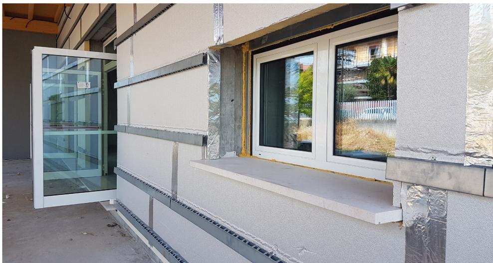
funzionale alla posa del rivestimento in lastre 120x60 cm in gres porcellanato di Emilgroup, ancorato ai correnti metallici con morsetti in acciaio a vista. Particolare **anche la metodologia di posa delle lastre a giunti sfalsati**, che si è in ogni caso rivelata semplice e veloce grazie alla versatilità del sistema ISOTEC PARETE. L'ingresso principale è sovrastato da un'ampia tettoia in legno lamellare, mentre in corrispondenza dell'ingresso posteriore è stata
