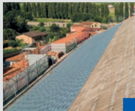
Il Sistema Isotec è una soluzione universale per l'isolamento ed il riefficientamento della copertura. È infatti progettato per essere applicato su tutte le coperture a falda, con qualsiasi tipologia di struttura portante, tramite appositi fissaggi meccanici.
