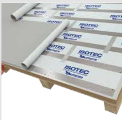
2 - Una volta ultimata la posa dei pannelli, siliconati e nastrati i giunti, stendere il telo impermeabile/traspirante sui pannelli.
