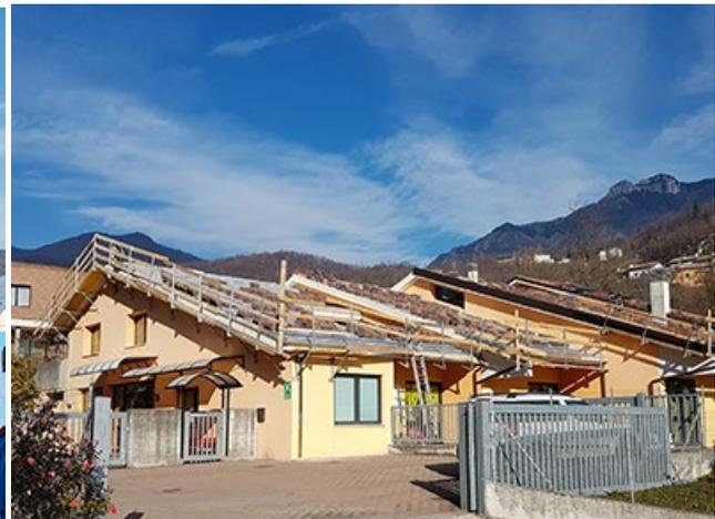
L'intervento di efficientamento energetico ha previsto una variante migliorativa al progetto iniziale con l'adozione del sistema **ISOTEC di Brienza Plastica**, spessore 100 mm, per realizzare l'**isolamento termico ventilato** dei quasi 500 mq di copertura.
