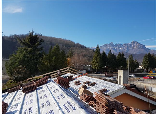
Per l'esecuzione dei lavori sono state necessarie soltanto due settimane da parte di 3 operatori dell'azienda Corte Costruzioni che ha eseguito l'opera. La posa del sistema Isotec è avvenuta direttamente sulla struttura in cemento **con posa completamente a secco**. Questa metodologia di fissaggio ha reso possibile la lavorazione nella stagione invernale anche in presenza di basse temperature.
