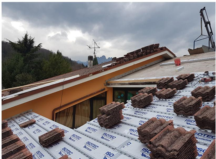
Per la realizzazione dell'opera sono stati utilizzati i molteplici accessori di completamento del sistema ISOTEC proposti da Brianza Plastica a corredo del sistema. I giunti laterali dei pannelli, sagomati a coda di
