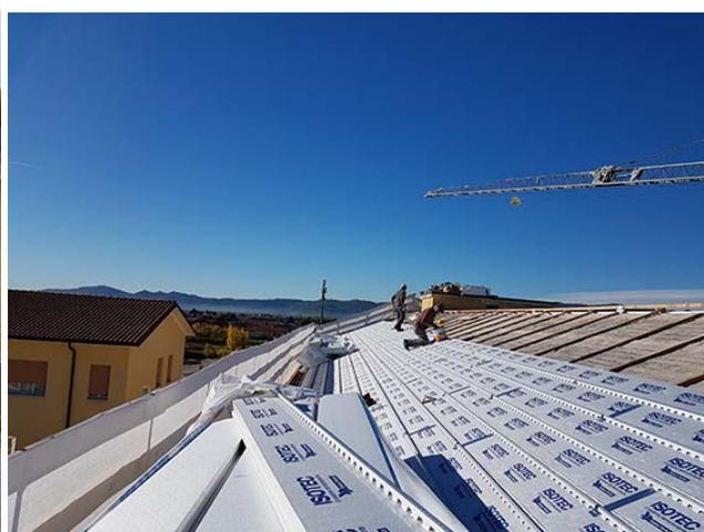
Per risolvere tali problematiche in maniera efficace è stato scelto il sistema termoisolante ISOTEC di Brianza Plastica, un **sistema completo per coperture ventilate** costituito da pannelli in poliuretano espanso rigido
