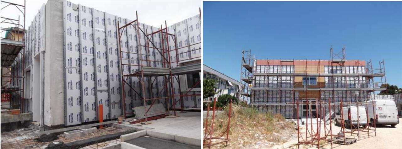
**Isotec Parete** è costituito da un pannello in poliuretano espanso rigido schiuma poliuretanicamente espansa rigida autoestingente, reso portante da un correntino asolato in acciaio protetto, che costituisce la camera di ventilazione e la struttura di supporto per il rivestimento delle facciate.
