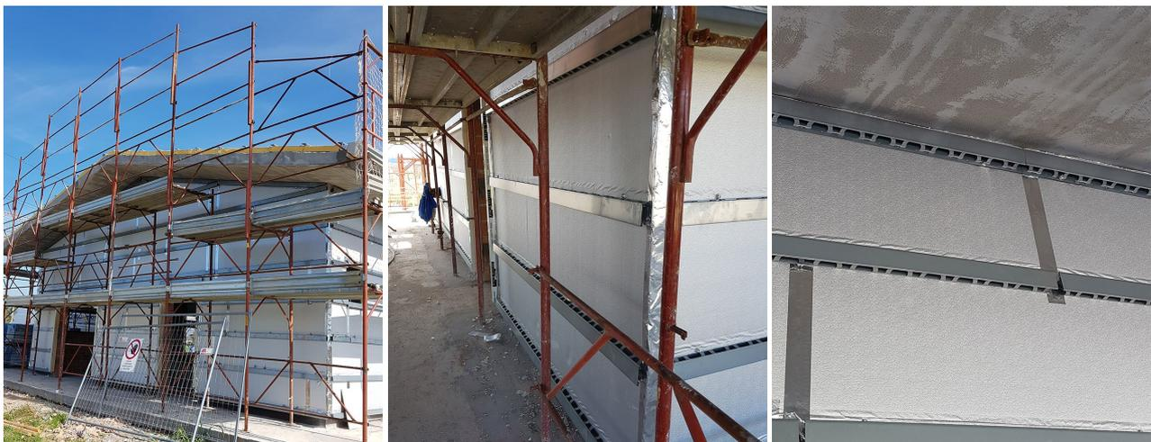
Tale profilo metallico consente il **fissaggio di qualsiasi tipologia di finitura della facciata**: inoltre la sua asolatura permette di creare un flusso di ventilazione naturale tra l'isolante e il rivestimento esterno.
