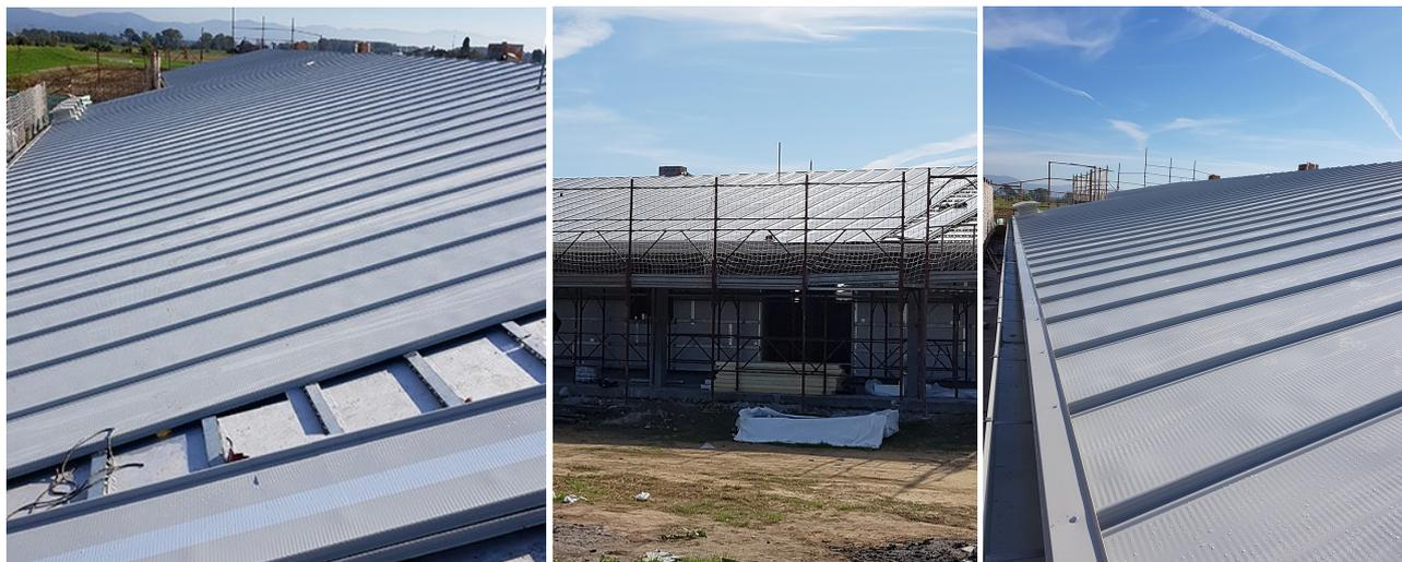
Anche in questo caso i pannelli Isotec Parete sono stati scelti nello spessore isolante 80 mm, con una resistenza termica dichiarata  $R_D$  di 3,60  $m^2K/W$  e conduttività termica  $\lambda_D$  0,022  $W/mK$ . L'asolatura del profilo metallico integrato nel pannello, consente l'**attivazione di un passaggio costante di aria** sotto il rivestimento, **dalla gronda al colmo**, e permette lo smaltimento dell'acqua che accidentalmente può
