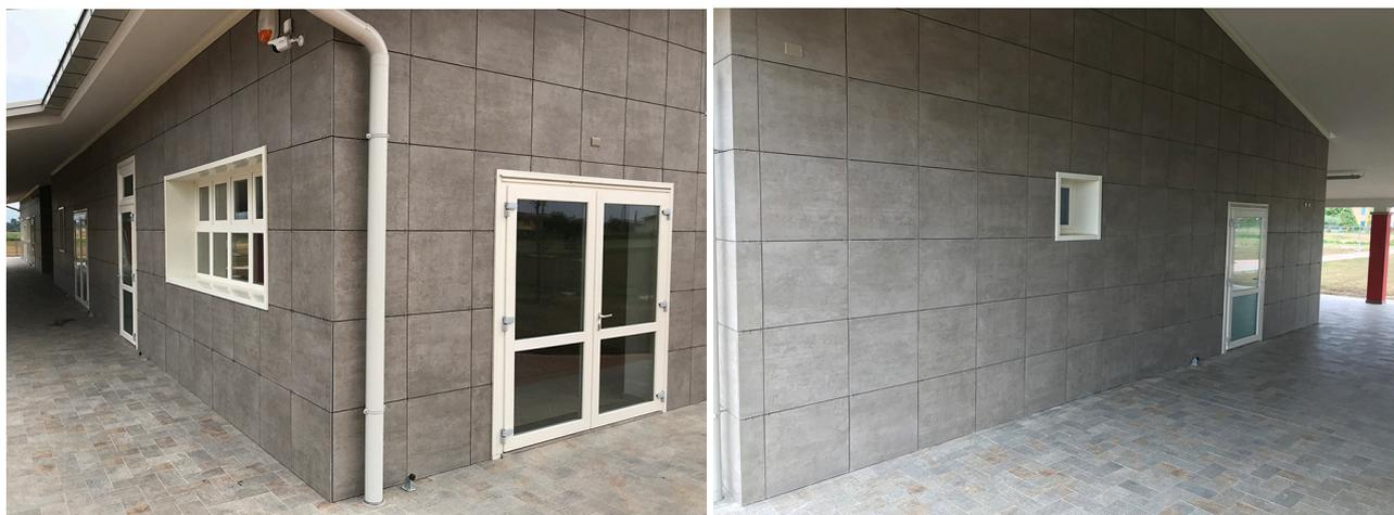
Una volta ultimata la posa a secco dei pannelli Isotec Parete, fissati con tasselli alla struttura muraria, l'impresa **Itaf srl** che ha eseguito la realizzazione, ha potuto completare il rivestimento delle facciate con estrema semplicità, fissando le **lastre in gres porcellanato 60x60 cm** di Emilceramica, scelte in un elegante colore grigio pietra, sull'orditura metallica formata dai correntini del sistema Isotec Parete, mediante idonei morsetti in acciaio.
