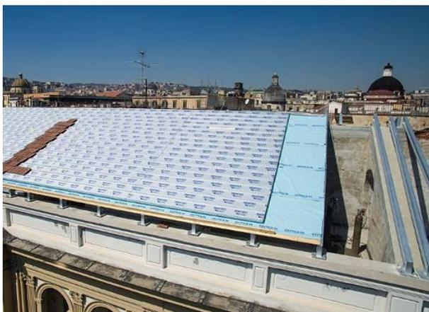
sistema Isotec ha permesso di realizzare velocemente e senza nessun aggravio di peso sulle strutture esistenti, un sistema a secco che ha garantito **il pieno rispetto delle vigenti normative sul risparmio energetico**.
