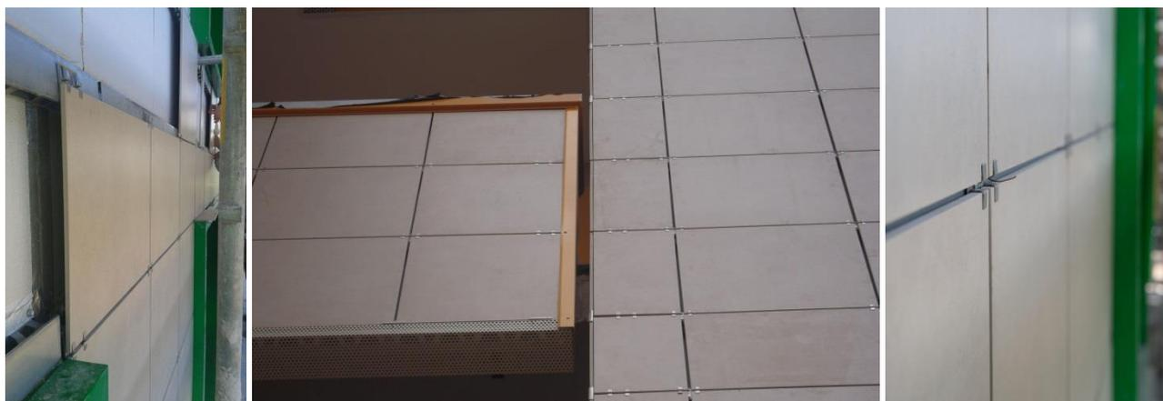
Per conseguire questi risultati, fra i diversi interventi, è stata prevista la **realizzazione di facciate ventilate per l’isolamento dell’involucro con Isotec Parete in spessore 100 mm**. Il sistema isolante ventilato **Isotec Parete di Brianza Plastica**, è composto da pannelli termoisolanti con anima in poliuretano espanso rigido autoestinguente, rivestiti su entrambe le facce da uno strato impermeabile in lamina di alluminio gofrato e resi portanti da un profilo nervato in acciaio protetto.
