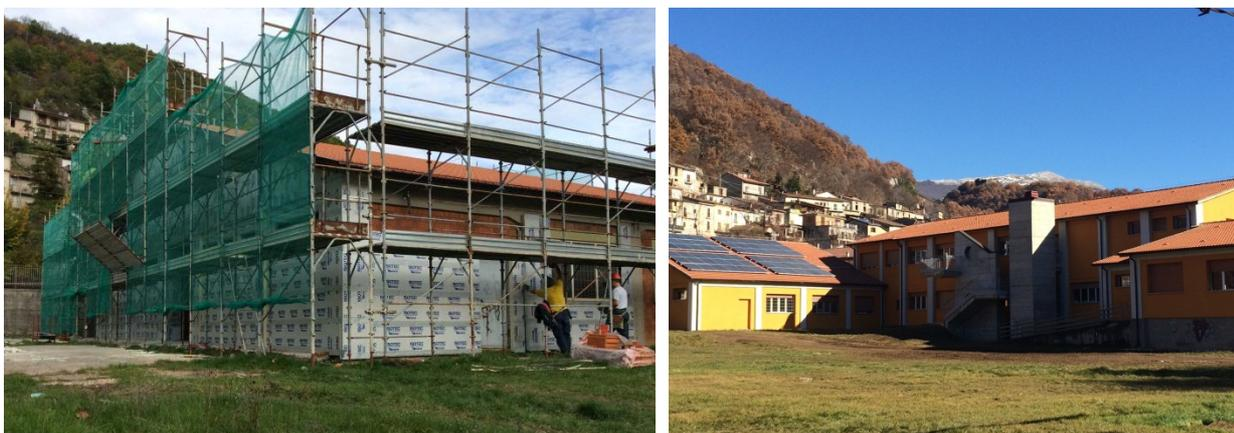
In più la scelta del sistema di isolamento portante ISOTEC LINEA all'interno del progetto di riqualificazione consente contestualmente di rielaborare e riprogettare l'estetica dell'edificio che in questo caso è stato rivestito con finitura ad intonaco sulle lastre in fibrocemento e pitturato con un vivo colore arancio.
