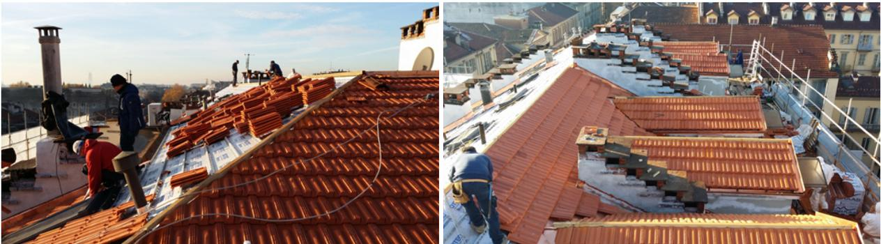
Il correntino in acciaio ha inoltre anche l'importante funzione di supporto per le tegole: una volta completata la posa dei pannelli, si può agevolmente collocare le tegole sul correntino e procedere al fissaggio delle stesse secondo le prescrizioni della Norma UNI 9460.
