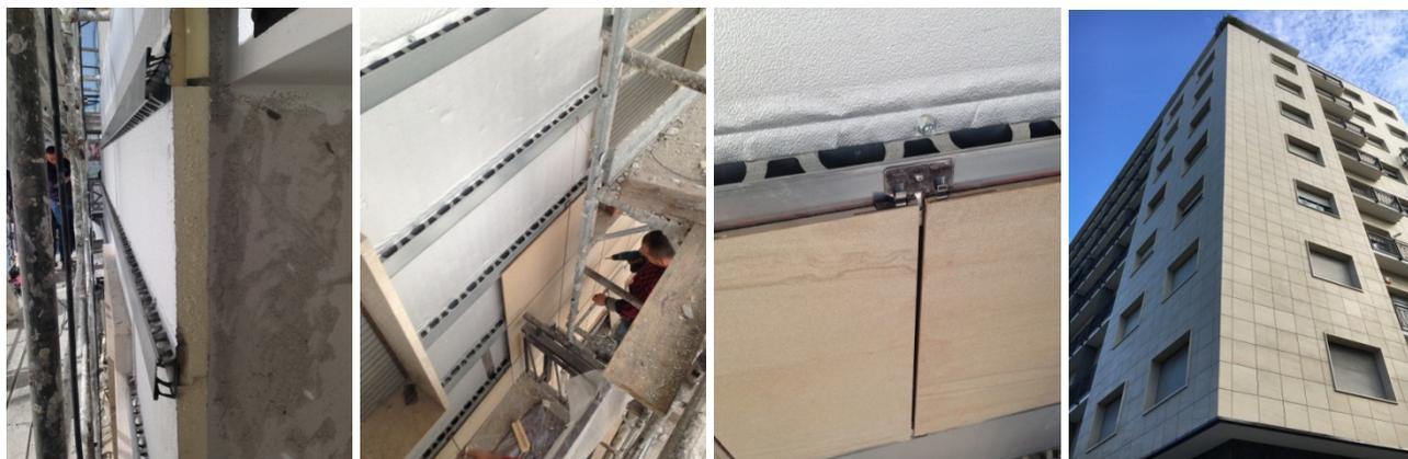
Il flusso continuo d'aria ascendente all'interno della camera di ventilazione comporta un miglioramento delle prestazioni termiche della parete asportando il calore in eccesso dovuto all'irraggiamento del rivestimento esterno nella stagione estiva e, nella stagione invernale, agevola lo smaltimento dell'umidità all'interno della camera d'aria, riducendo i rischi di condensa.
