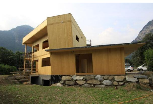
Nel caso dell'abitazione di Chiavenna, ISOTEC PARETE è stato abbinato ad un rivestimento in doghe di larice naturale, disgiunte tra loro, e ad una seconda finitura, costituita da lastre in fibrocemento intonacate e tinteggiate.
