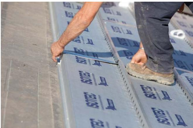
**ISOTEC** è infatti un sistema di isolamento termico in poliuretano espanso rigido per coperture a falde, i cui pannelli, in sequenza di posa, realizzano rapidamente un impalcato **portante, termoisolante, impermeabile** alle infiltrazioni accidentali del manto di copertura e **microventilato**, grazie al correntino in Aluzinc di cui sono dotati.
