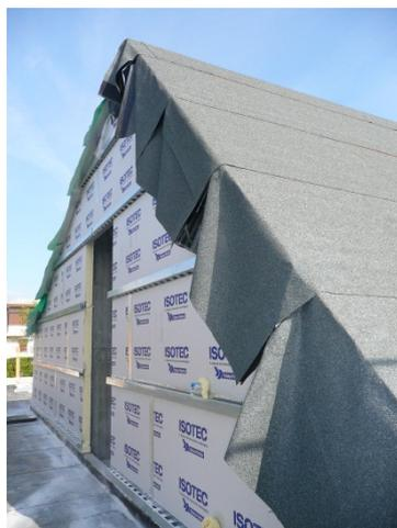
rivestimento di facciata e pannello isolante consente, soprattutto nella stagione estiva, un miglioramento delle prestazioni termiche, asportando il calore dovuto all'irraggiamento diretto sulle lastre in alluminio, e in inverno permette lo smaltimento della condensa che si crea all'interno della camera d'aria per raffreddamento.
